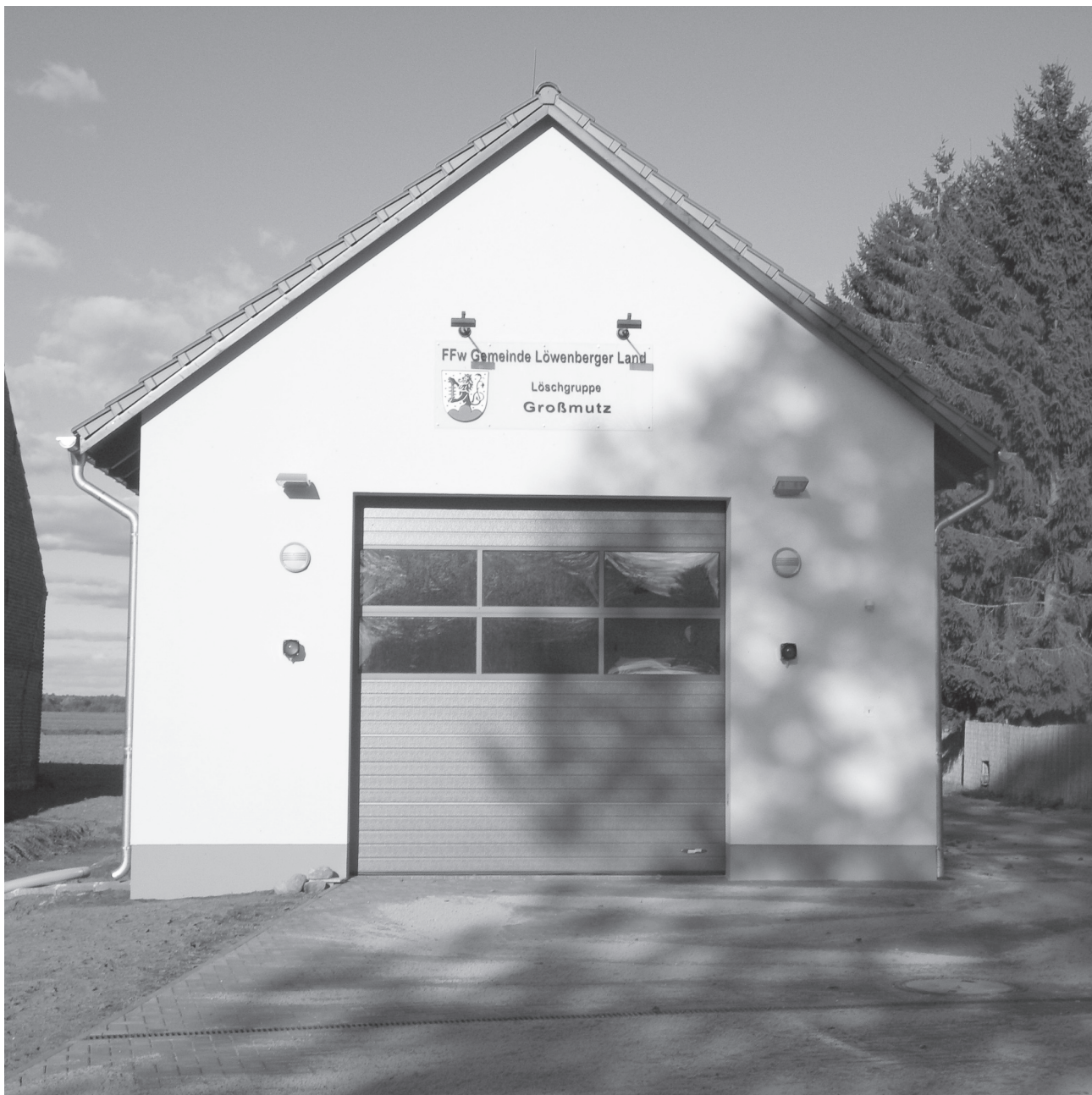
Fertigstellung der Feuerwehrfahrzeughalle in Großmutz
